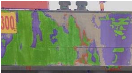
NACH REFERENZBILD EINGEFÄRBTE PRÄDIKTION (ZUGESCHNITTEN) DES DEEPLAB V3+ (LINKS) UND RANDOM FOREST (RECHTS). GRÜN STELLT DIE KORREKTE KLASSIFIKATION DAR, BLAU IST EIN FALSCH ERKANNTER SCHADENSBEREICH UND ROT VISUALISIERT ÜBERSEHENE KORROSIONSTELLEN.
